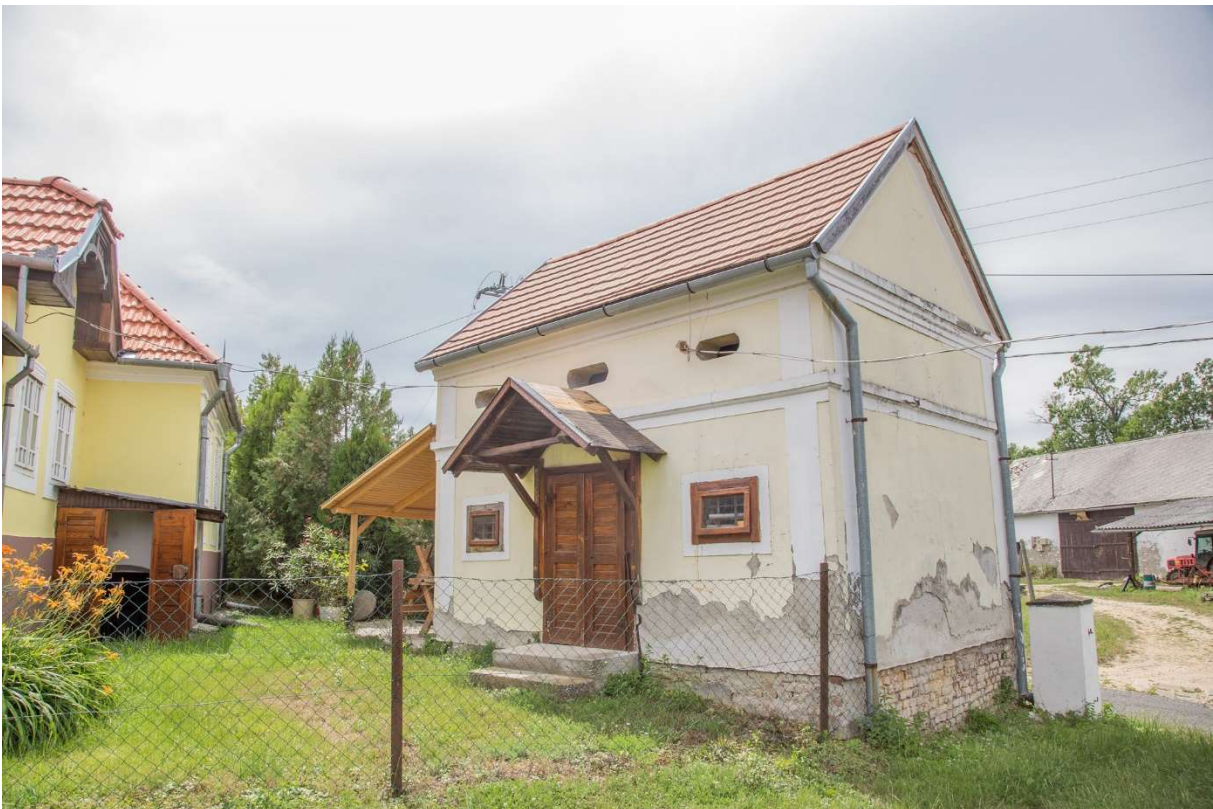
Lakóház és gazdasági épület Petőfi utca 2. hrsz. 141/5
