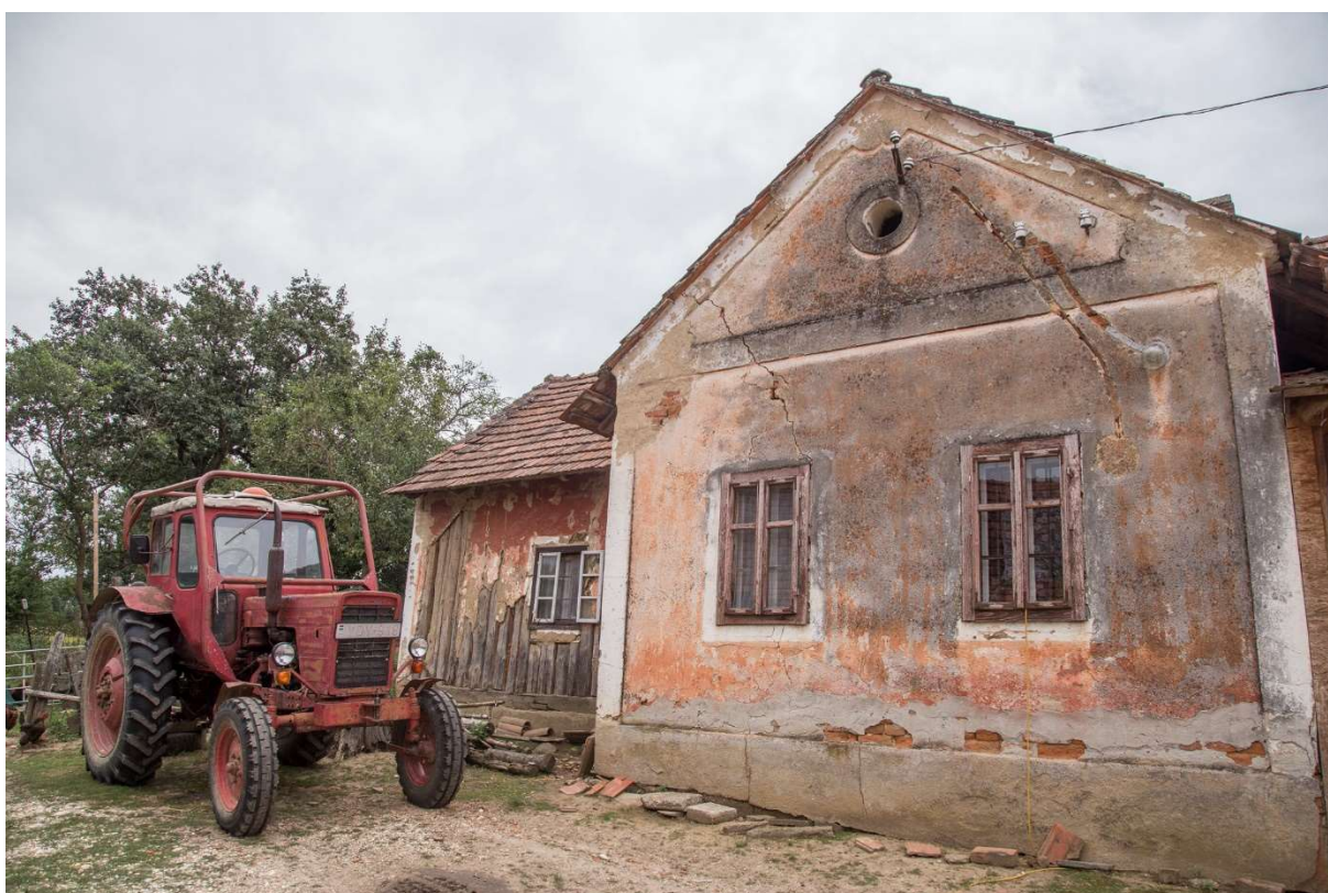
Lakóház Fő utca 36. hrsz. 109
