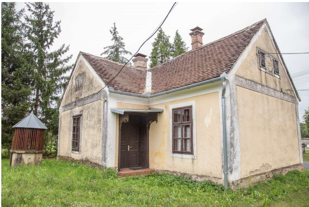
Lakóház Fő utca 32. hrsz. 112
