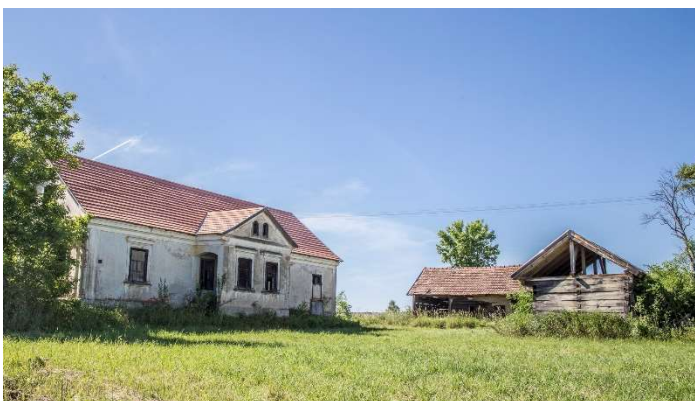
8. Lakóépület és melléképülete Farkasi utca 6. hrsz: 801
